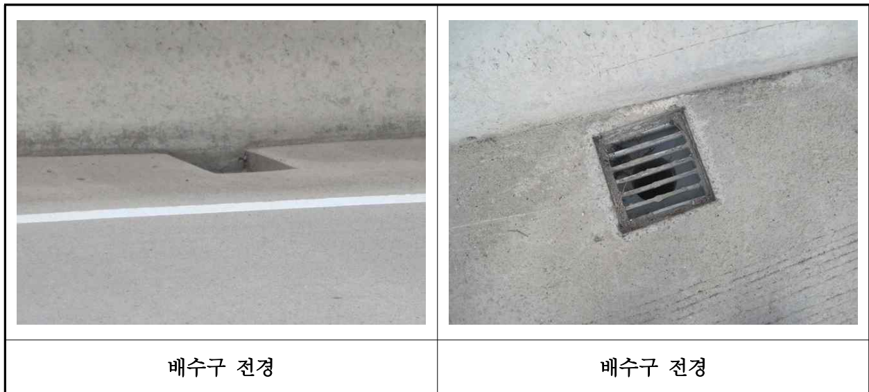
【사진 1.3.21】 배수시설 전경
