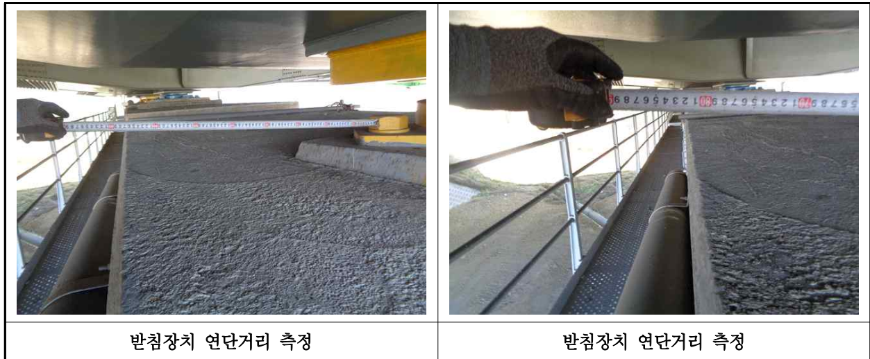
【사진 1.3.14】 교량받침장치 연단거리측정
