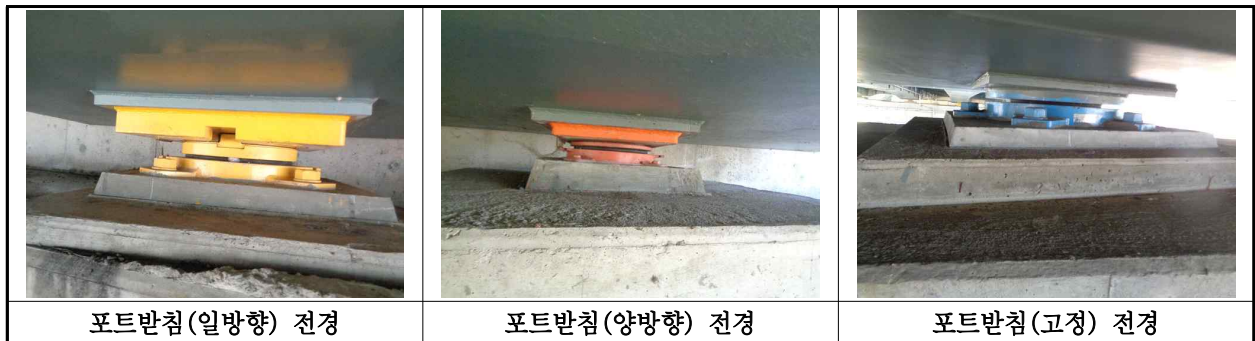
【사진 1.3.12】 교량받침 전경
