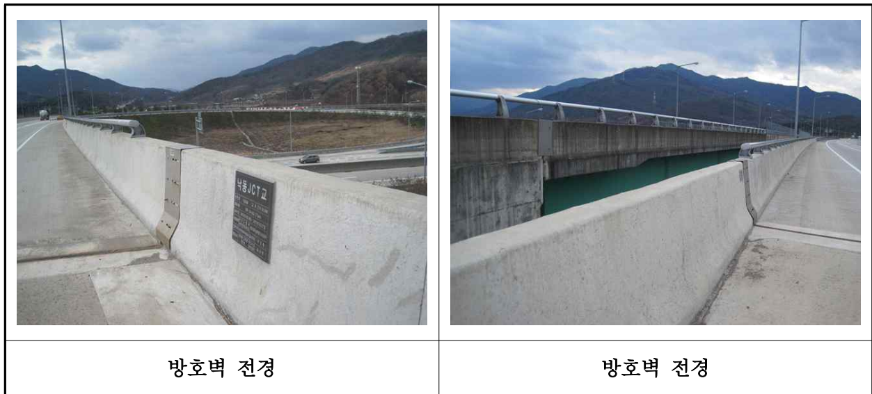
【사진 1.3.23】 방호벽 및 중앙분리대 전경
