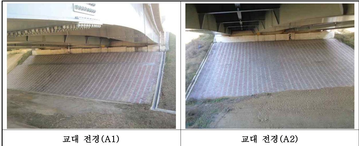
【사진 1.3.8】 교대 전경
