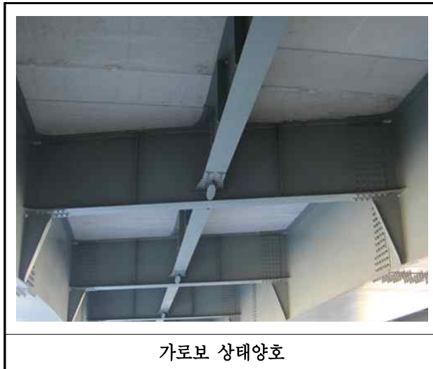
【사진 1.3.7】 가로보 손상현황
