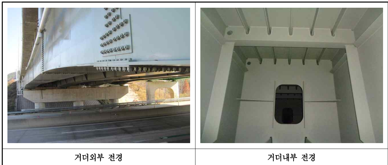
【사진 1.3.4】 거더 전경
