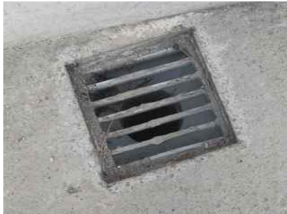
배수시설 상태 양호
