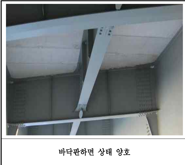
【사진 1.3.3】 바닥판하면 손상현황
