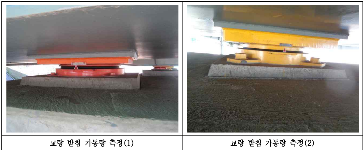
【사진 1.3.15】 교량받침 이동량 측정
