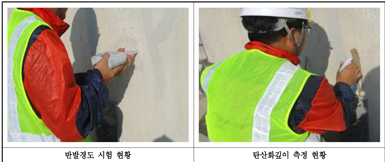
【사진 1.4.1】 콘크리트 내구성조사 현황
