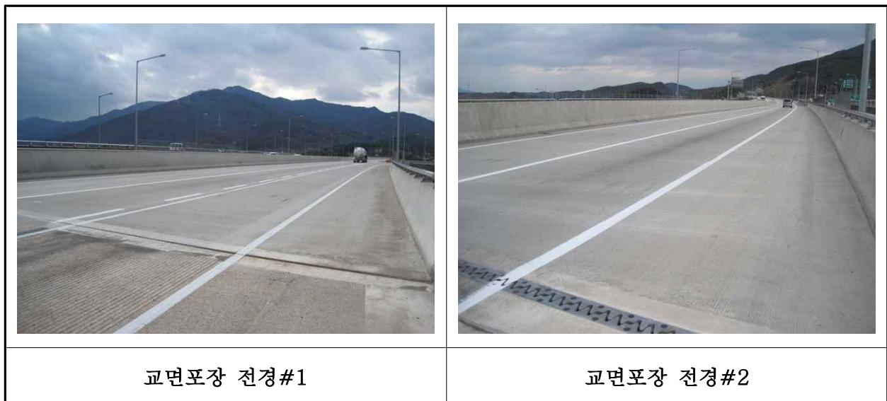
【사진 1.3.19】 교면포장 전경
